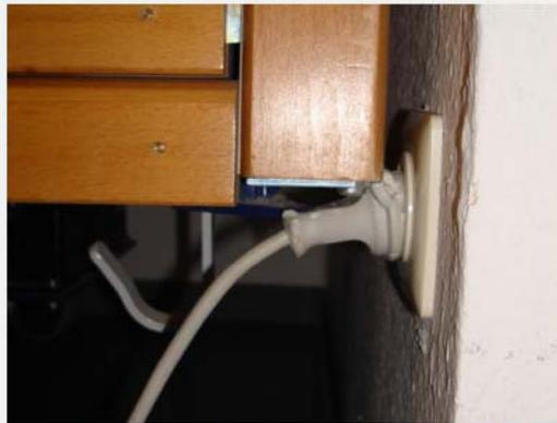
Abb. 11: Netzstecker im Bewegungsbereich eines Elektrobettes
